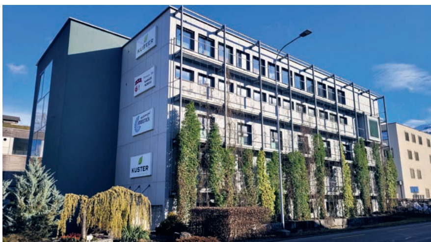
In Oberdorf hat das GaLaBau-Team ein modernes Gewerbegebäude mit grosszügigem Werkhof.
