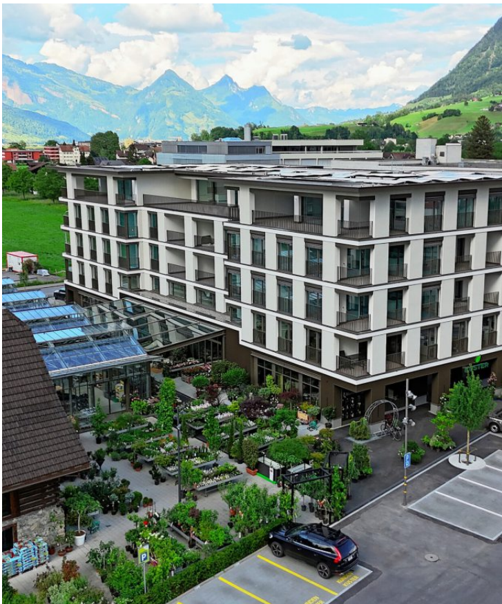
Nach 18-monatiger Bauzeit wurden 2024 die Tore zum neuen Gartencenter und Blumengeschäft geöffnet.
